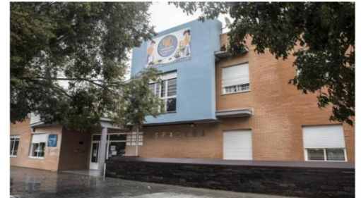
Edificio de dos alturas y sótano donde Aspaceba quiere construir una tercera planta. / PAKIOPH
